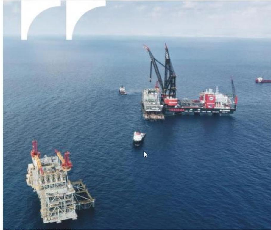
**Installation du jacket , des piles et du topside à partir d'un navire de levage**
