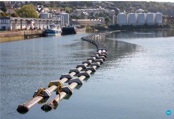
Les fourreaux nécessaires à l'ouvrage à l'atterrage peuvent potentiellement être assemblés à terre puis amené en mer. Ces fourreaux peuvent faire plusieurs centaines de mètres de long.
