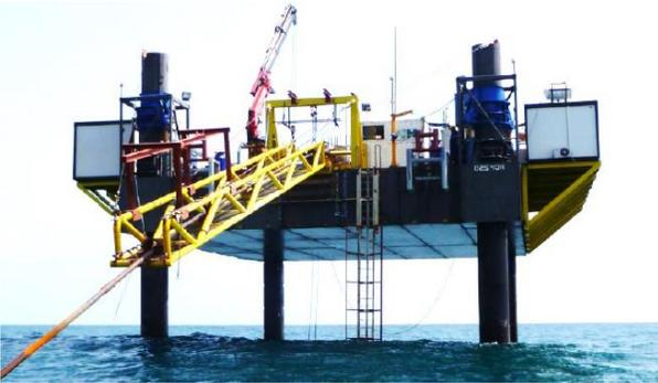
Les travaux à l'atterrage peuvent nécessiter l'utilisation de moyens nautiques dans l'estran ou à proximité des côtes, comme une barge jack-up (à gauche) pouvant assister la réalisation de forages dirigés terre-mer.
