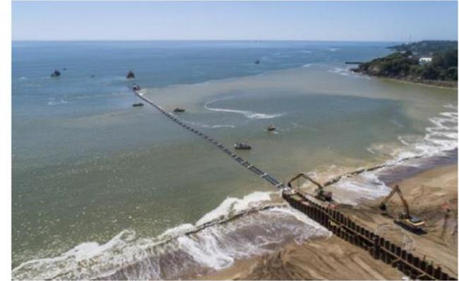
Les travaux en partie haute de la plage sont réalisés avec des moyens terrestres classiques. En partie basse, ils sont réalisés soit avec des moyens terrestres adaptés, de type pelle surélevée permettant de travailler dans l'eau, ou avec des moyens nautiques, de type pelle excavatrice sur ponton flottant (BHD)
